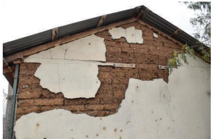
65.- Estructura muro testero iglesia de Mialqui, de adobe reforzado con madera en área de cubierta.
