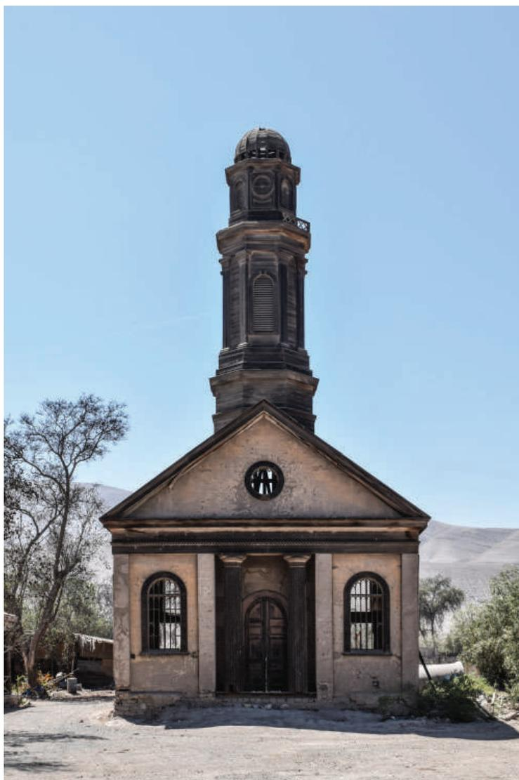
Las recopilaciones realizadas en el Valle de Limarí y en Tierra Amarilla (Segovia y Ferrada, 2007 y Dransfeld et al., 2022, respectivamente), señalan que la ventaja de la quincha es su resistencia sísmica, debido a la flexibilidad de la estructura de madera y a las uniones flexibles de dicho sistema constructivo. “Esto permite construcciones de mayores dimensiones con muros relativamente delgados” (Dransfeld, et al., 2022, p. 30-32).
