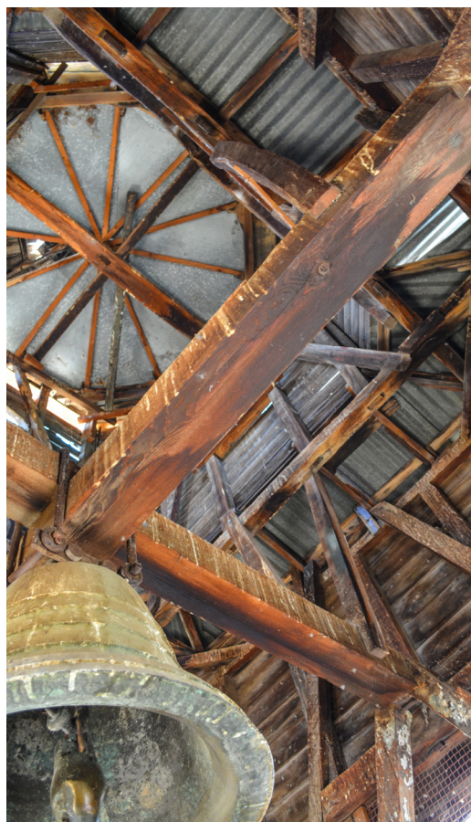
Detalle de estructura campanario.
