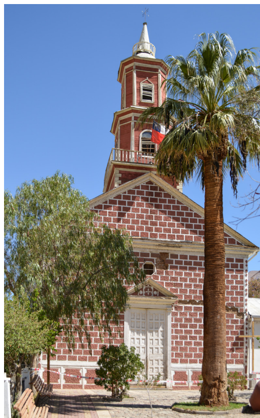
Fotografía frontal Iglesia de Montegrande.
