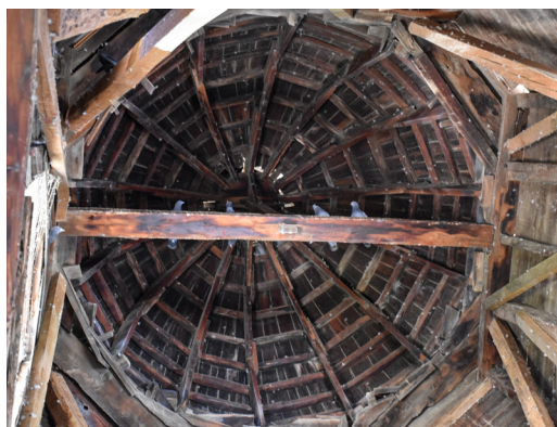
Detalle estructura de chapitel.
