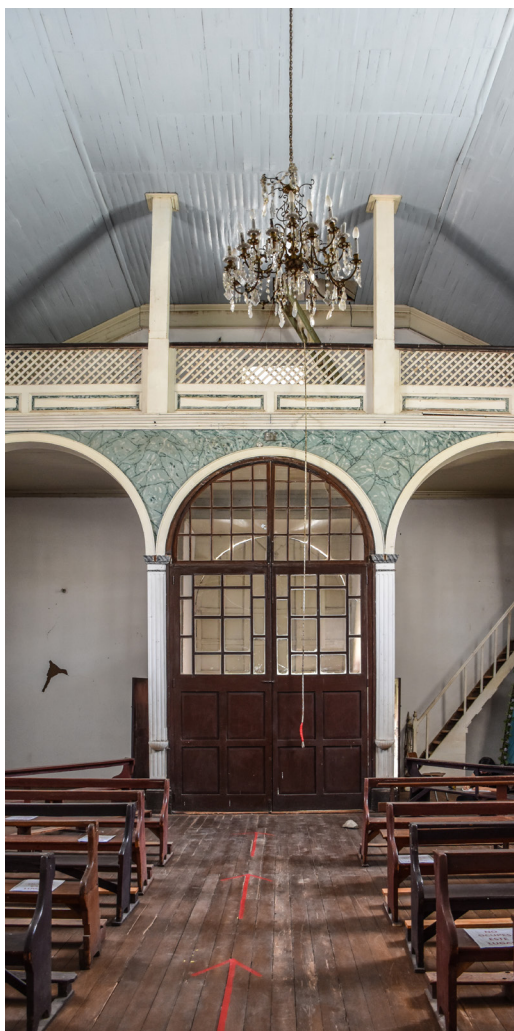
Vista hacia el acceso.
