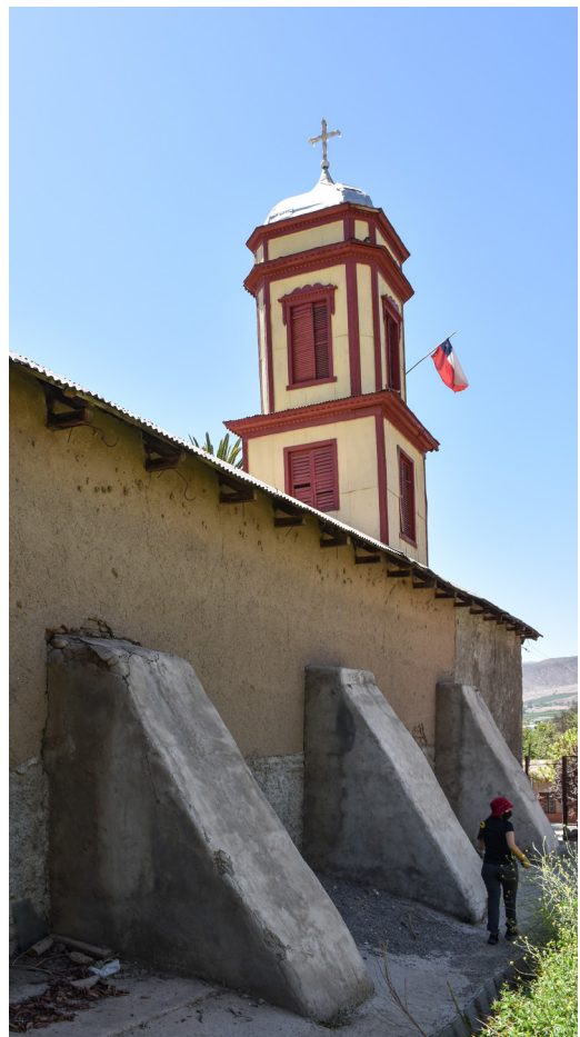
Fotografía exterior contrafuertes laterales.
