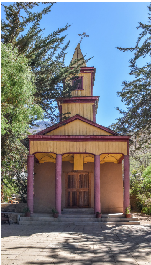
Fotografía frontal fachada Iglesia de Alcohuaz.
