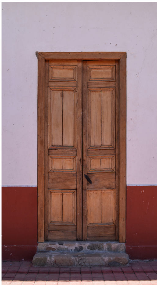
Detalle puerta lateral.
