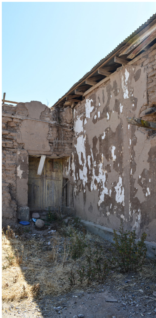
Detalle interior, donde se puede apreciar estructura de madera inserta en albañilería de adobe.
