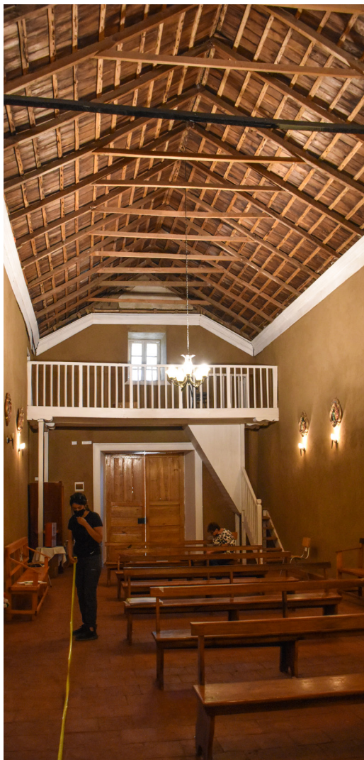
Vista hacia el acceso.
