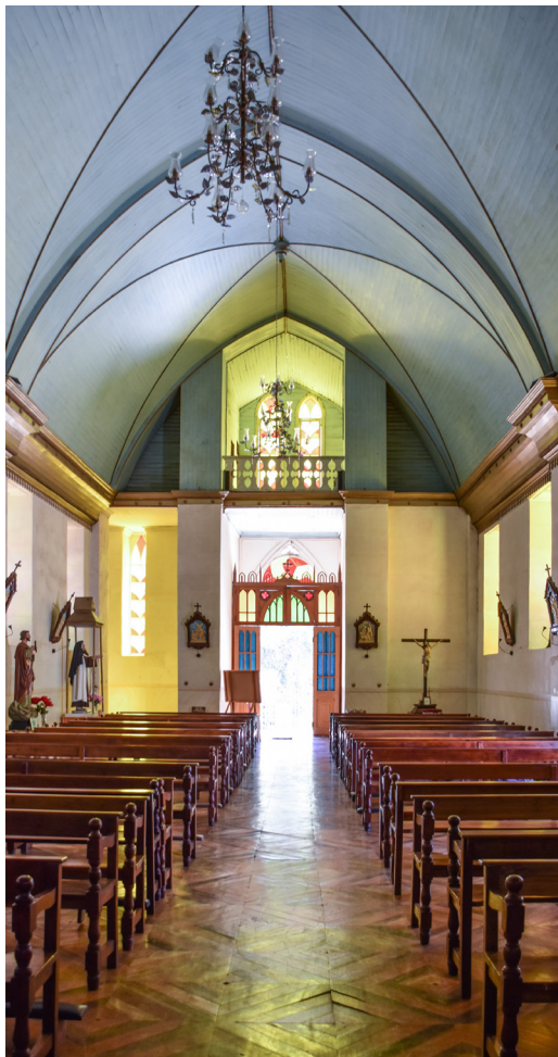
Vista hacia el acceso.
