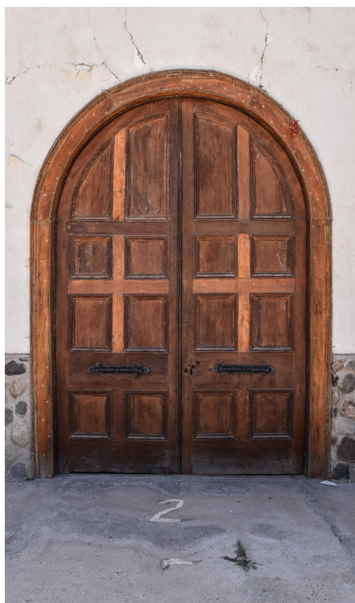
Detalle puerta principal.
